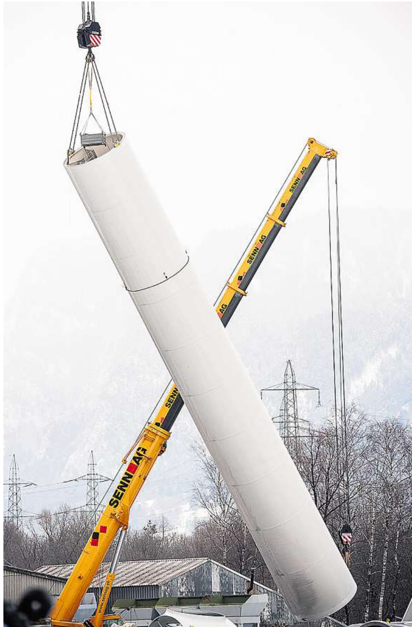
Ein imposantes X: Mit dem Aufbau der schweizweit grössten Windenergieanlage in Haldenstein wird ein Stück Bündner Energiegeschichte geschrieben.
